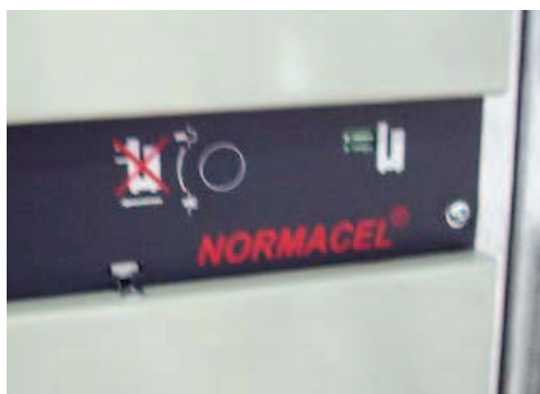
Vysunuto (revizní poloha)
